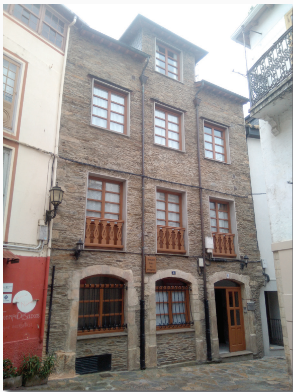
Imagen 2. Navia. Antigua casa del Hospital. Fotografía del autor, 2017.
