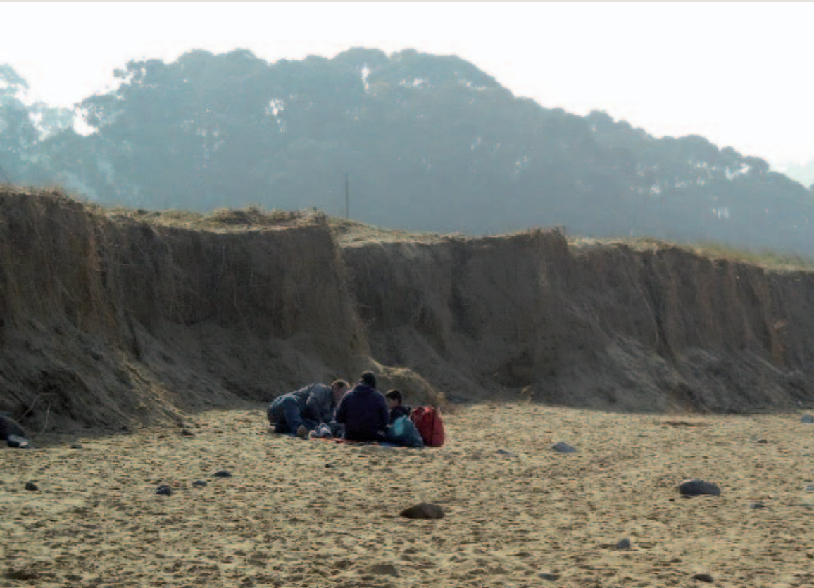
La Playa Rodiles viose afeutada sobre manera na so parte oriental, onde se formó un escalón de más de dos metros d'altor (marzu de 2014).
