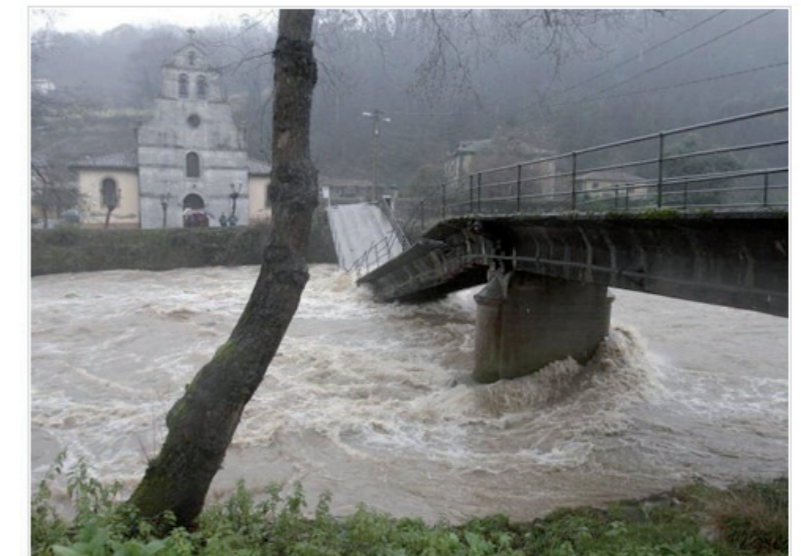
Un puente derribado sobre el río Trubia y se desborda el río Nalón en Asturias
