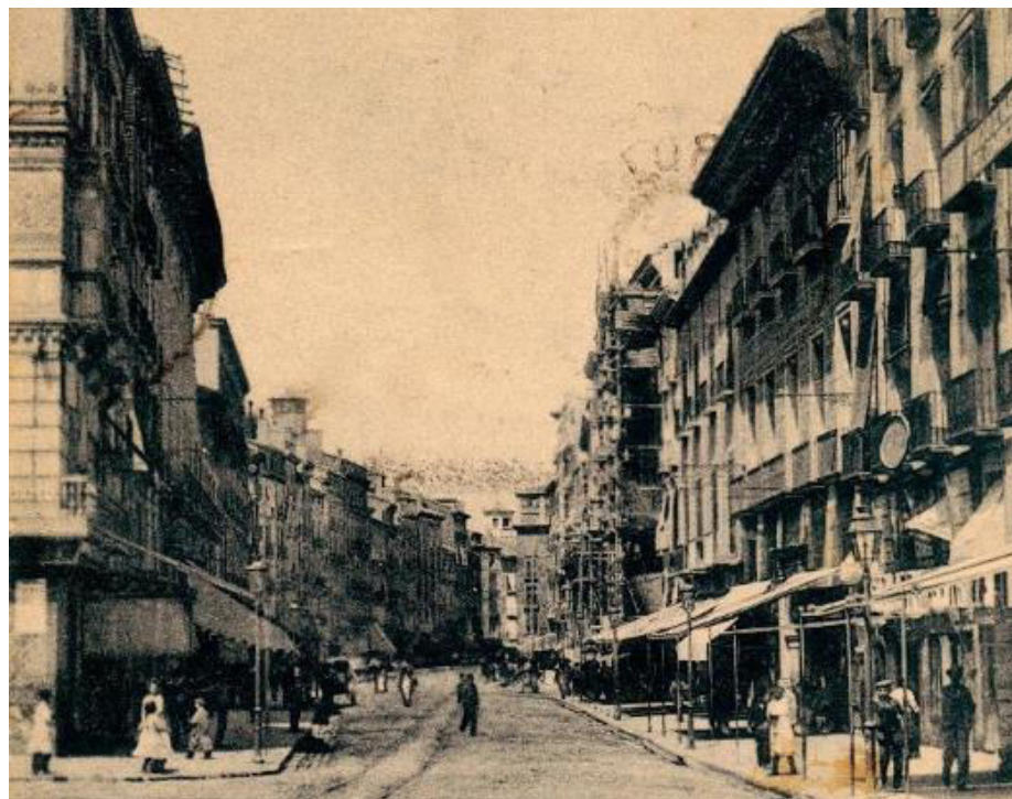
Fig. 2: Vista general, desde el este, del Coso Alto de Zaragoza en 1902. A la derecha, cubierta por andamios, se observa la que fuera casa de José Casanova, cuya fachada estaba siendo reedificada para su integración en la modernista Casa Molins. A su diestra se aprecian las fachadas de las antiguas casas de Juan Antonio Mexino y Martín Zapater y la del Palacio de los Duques de Híjar, dotada de un potente alero de madera.
