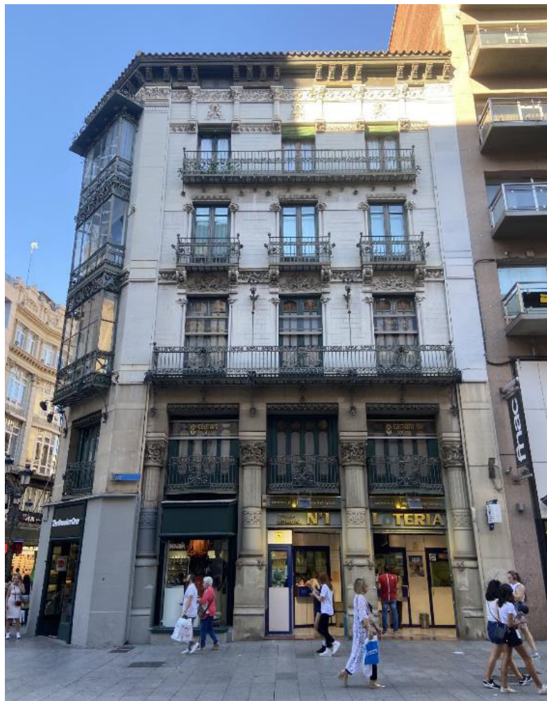
Fig. 8: Vista actual de la fachada meridional de la Casa Molins de Zaragoza, creada en 1902 integrando y enmascarando la antigua casa de José Casanova, aún conservada en su estructura y que corresponde a las dos hileras de vanos del extremo derecho.
