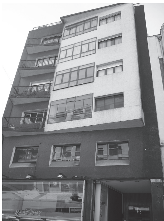
Fig. 1. Exterior del edificio realizado por Juan Vallaura en la calle Argüelles nº 7-9 de Oviedo (1957) para la sociedad Coya-Vallaura. Archivo personal.
