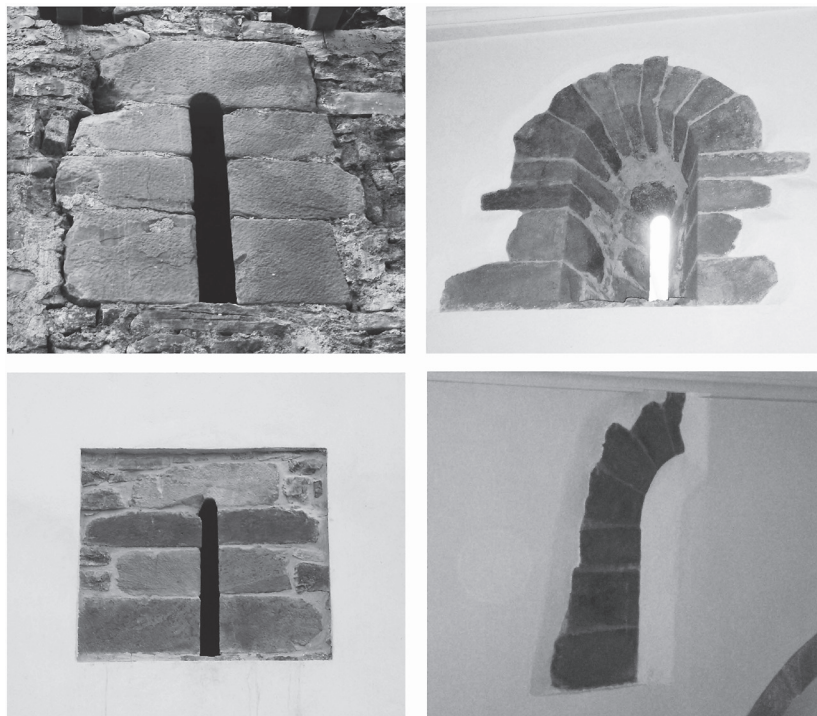
Fig. 5. Ventanas románicas tras la restauración. Superior derecha la ventana románica del muro norte vista desde el Almacén transformado en Despacho. Superior izquierda la misma ventana vista desde el interior y después de ser descubierta. Inferior derecha la ventana románica descubierta en el muro sur y vista desde el exterior de la Iglesia. Inferior izquierda la media ventana románica del muro sur embutida y cortada por el muro de la nave lateral, perpendicular al muro sur.
