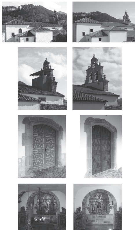
Fig. 4. Fotografías estado previo-estado reformado. Vista de la cubierta, del campanario, de la puerta de entrada y de la bóveda sobre la Nave Principal.
