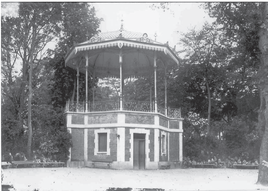
Fig. 11. Positivo de una placa de cristal, posiblemente del fotógrafo Luis Muñiz Miranda, h. 1920. Se aprecian las pinturas originales del intradós de la cúpula, con un supuesto revestimiento del tablero de madera mediante estuco decorado. Fuente: Archivo Real Instituto de Estudios Asturianos (RIDEA)
