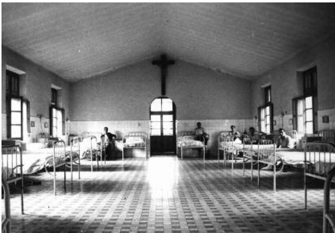
Fig. 4. Interior de una de las salas del Sanatorio Adaro en la década de 1950. Fuente: Archivo Grupo Duro Felguera
