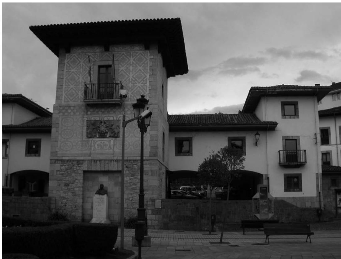
Fig. 4. Palacio Pintu con las viviendas de la Plaza del Mercado al fondo. Estado actual.
