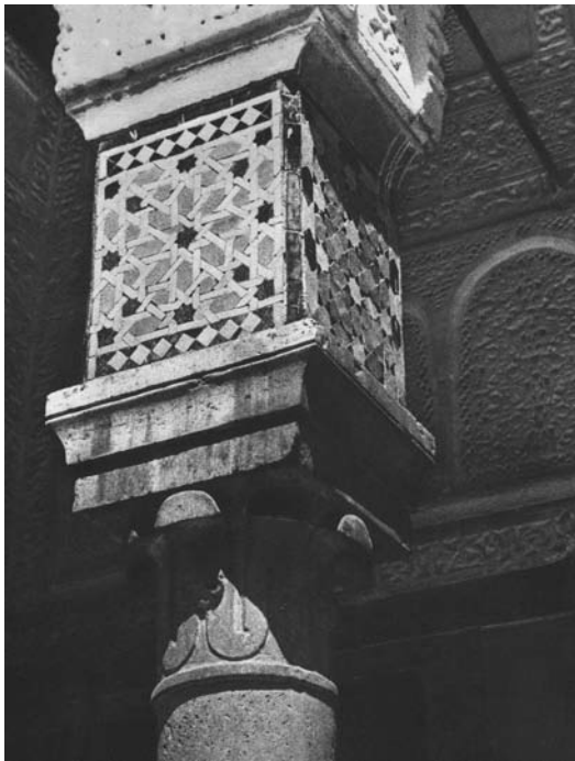
Fig. 3 – Dār Dawlātī, cour centrale, chapiteaux surmontés d'imposantes à décor de marqueterie céramique, xvii e siècle. Photothèque de l'Institut National du Patrimoine de Tunis, 1963.
