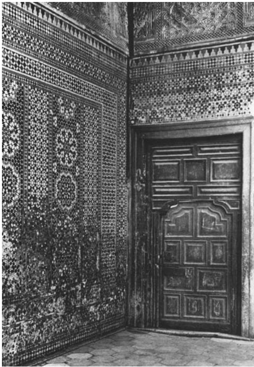
Fig. 1 – Dār Lağimi, patio à l'étage, marqueterie céramique qui couvre entièrement les parois, surmontée de panneaux de plâtre sculpté, d'après Jacques REVAULT, Palais et demeures de Tunis (XVI e - XVII e siècles) , 1967, p. 121, fig. 22.
