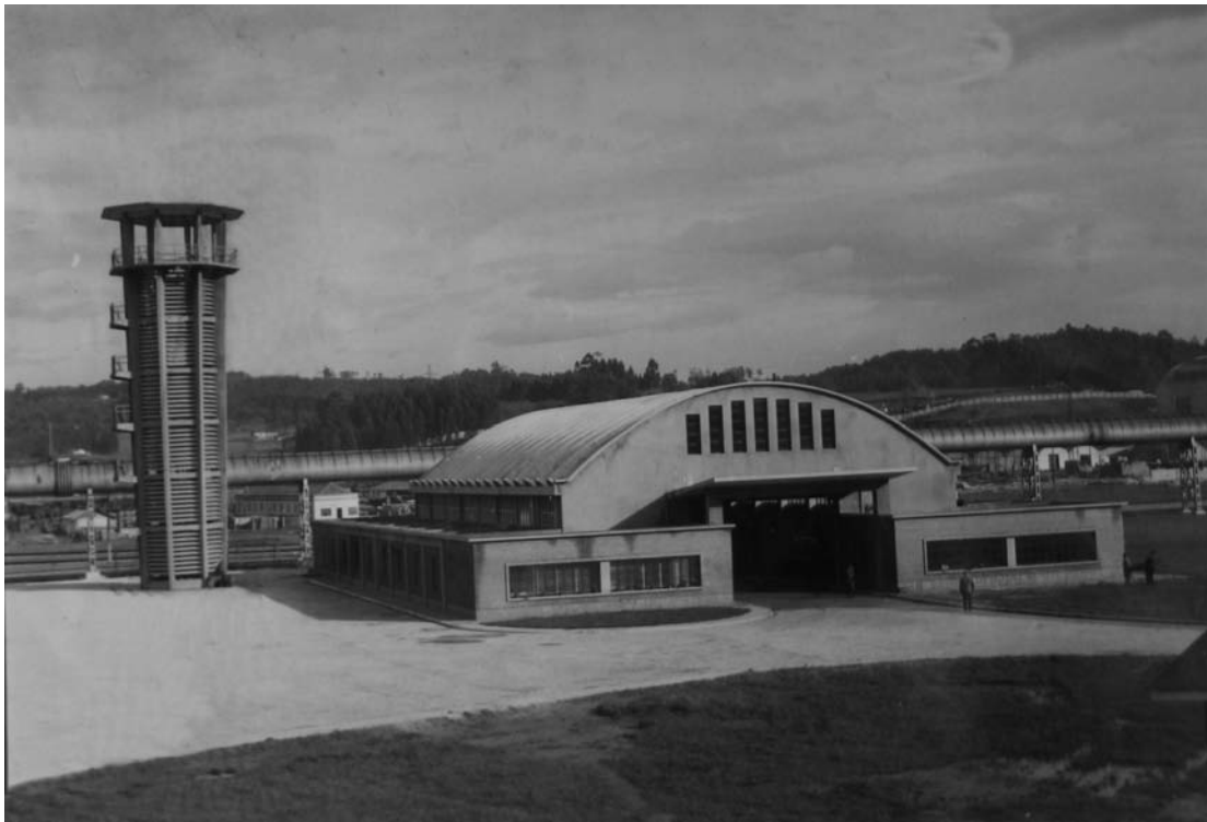
Fig.3. Conjunto de Parque de Bomberos y Torre exenta de ENSIDESA. Cárdenas Rodríguez. 1957-58. Fuente: Colección Armán. Centro de Documentación ArcelorMittal.
