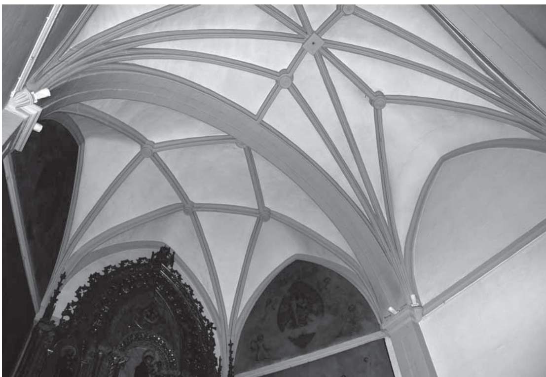
Fig. 3. Bóvedas de crucería que cubren el presbiterio, o último tramo de la nave del templo, y el ábside, ésta última adaptándose a la forma poligonal que adquirió el mismo durante estas obras.
