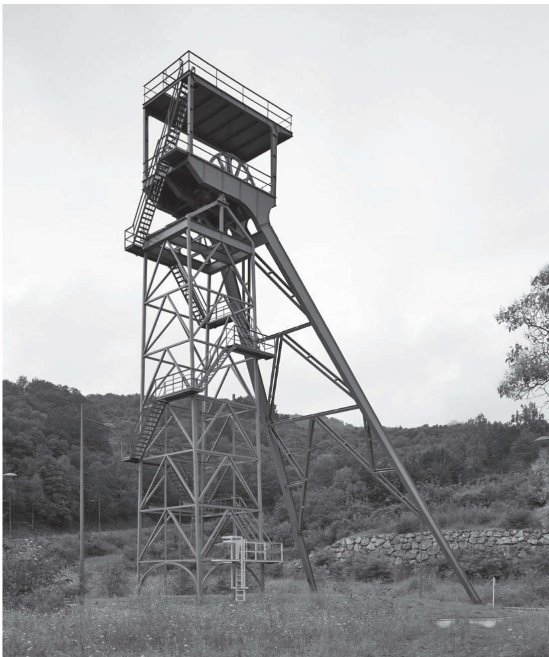
Fig.02 Vista general del castillete restaurado [fotografía Marcos Morilla]
