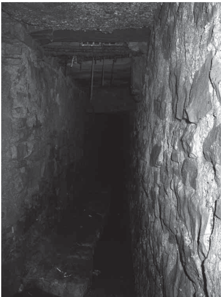
Fig. 2. Vista interior del acueducto de la Matriz (Fotografía: Cristina Heredia)*.
