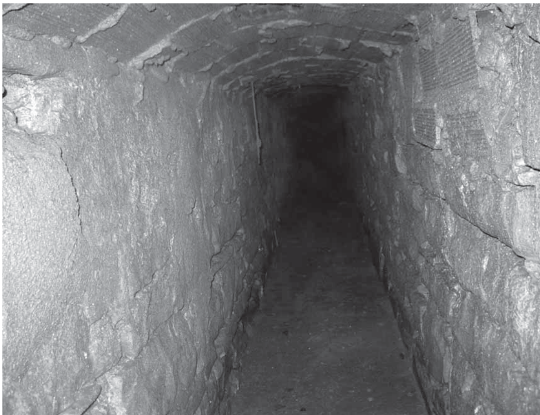
Fig. 3. Vista del interior del acueducto de la Matriz (Fotografía: Cristina Heredia).
