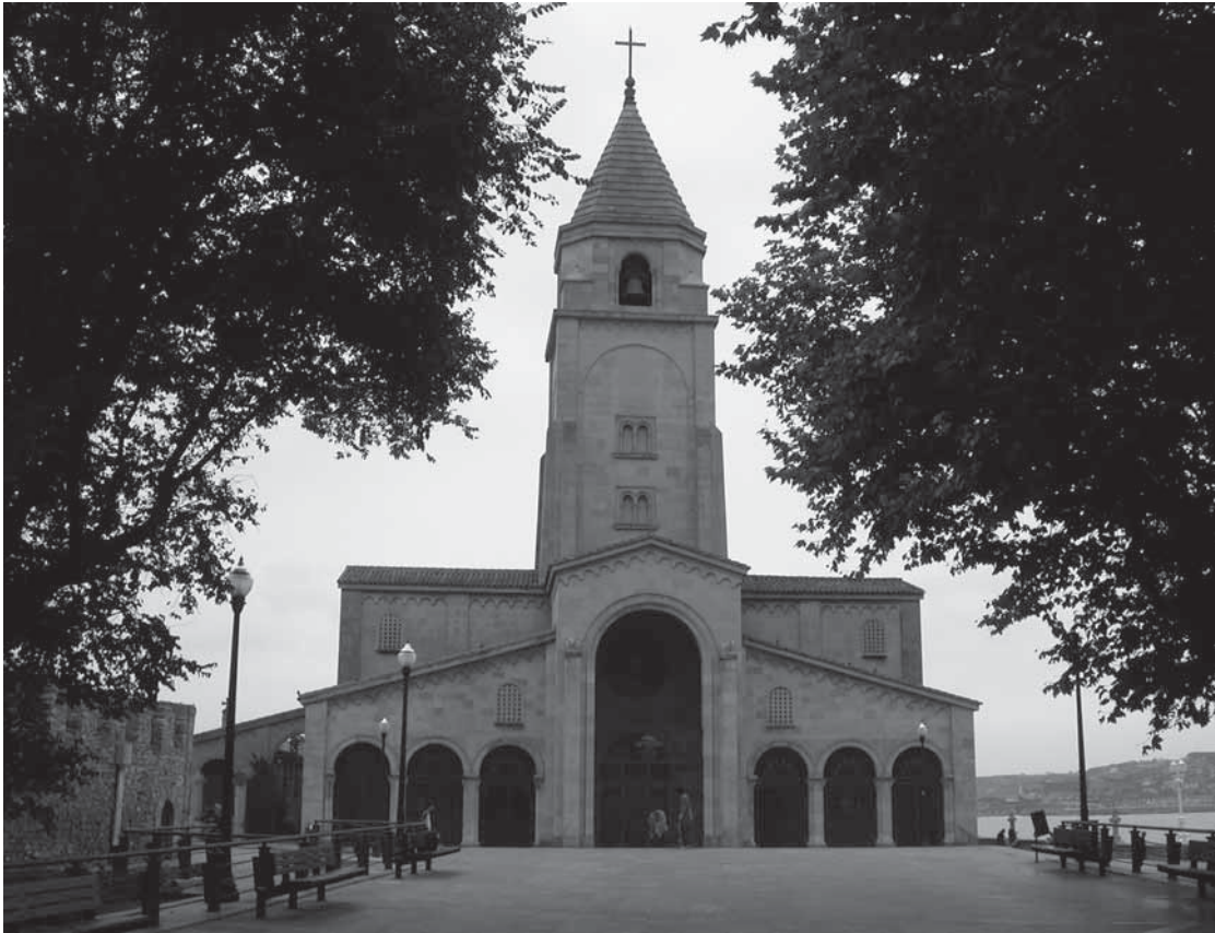
Fig. 5. Estado actual de la iglesia de San Pedro. Luis Andrés.
