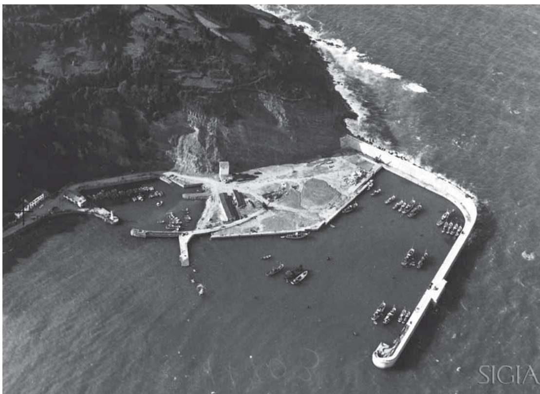
Fig. 4. Construcción del dique exterior y de la explanada de servicio, 1966. Fuente: Memoria Digital de Asturias.
