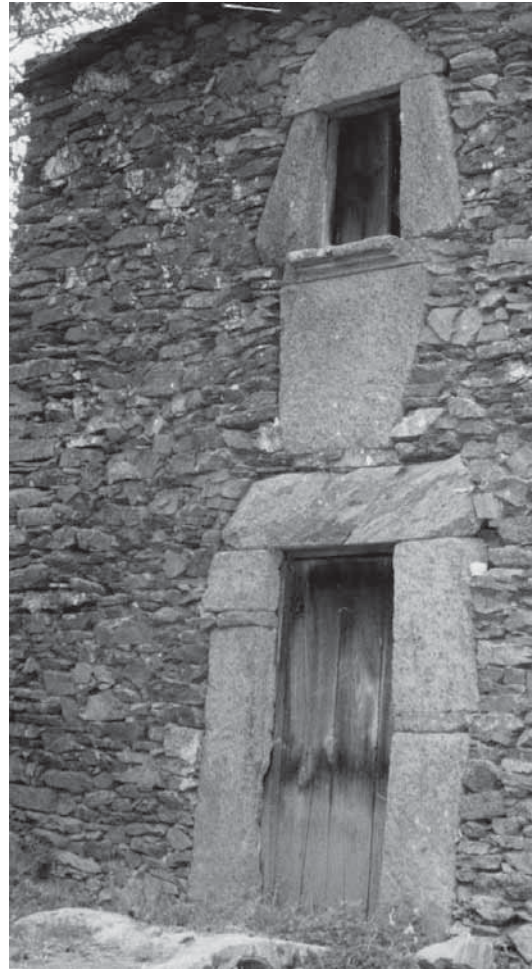
Fig. 4. «Casa de Novenas». Foto F.D-M (2006).
