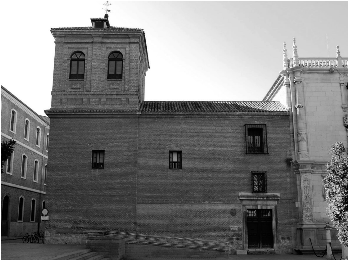
Fig. 1. Fachada principal del Colegio de San Pedro y San Pablo, Alcalá de Henares (1508-1511). Fuente: Fotografía de Raimundo Pastor.
