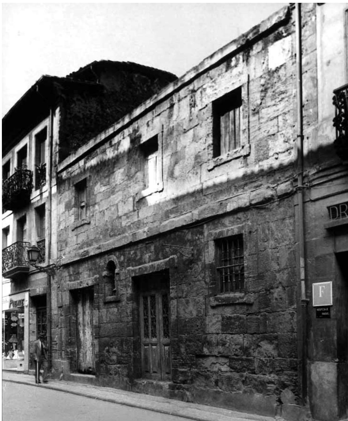
4. Fachada del hospital y capilla de la Magdalena, 1979, fotografía que acompaña al proyecto del arquitecto Manuel Calvete Llamas (A. M. O.).
