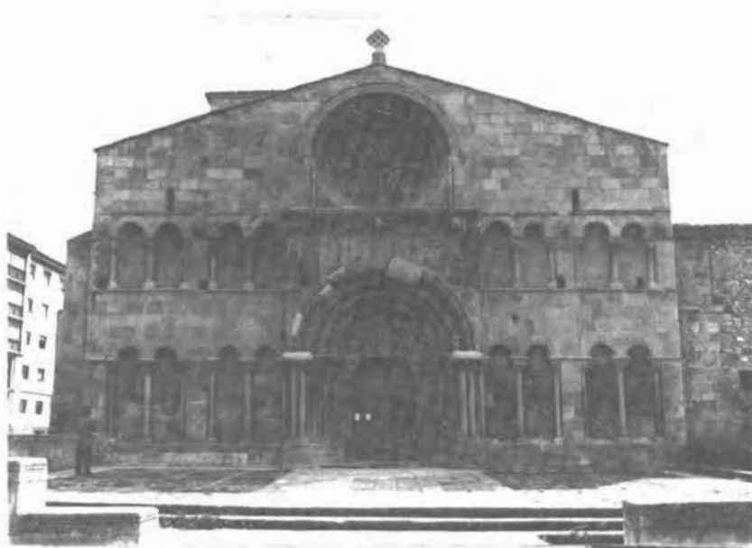
Fotografía 1. Vista general de la fachada oeste.
