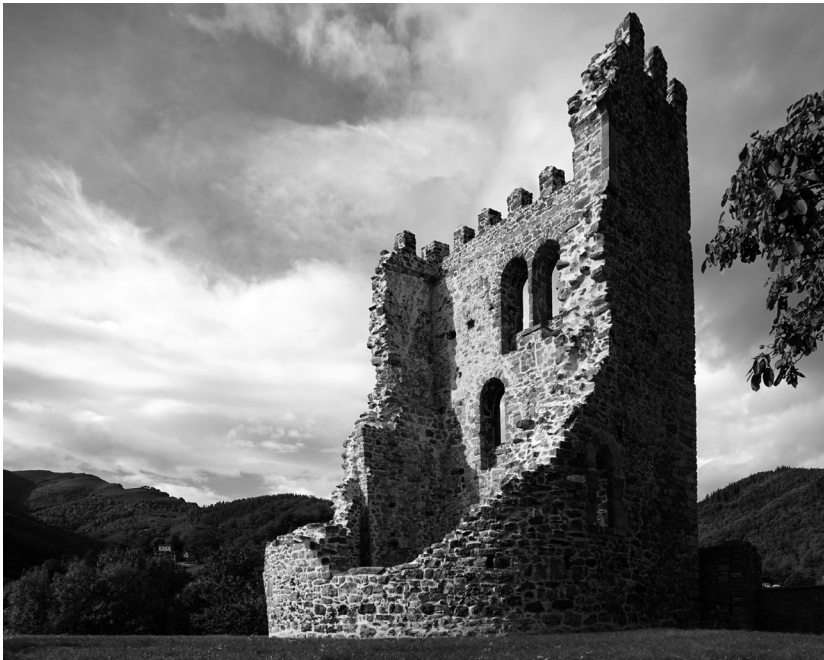
Fig. 1. Torre del castillo de Soto tras la finalización de las obras. Agosto de 2022. Fotografía del autor.
