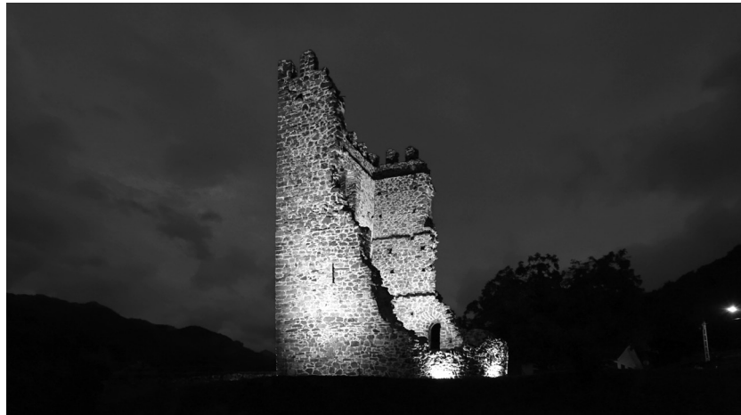
Fig. 4. Torre de Soto iluminada tras la intervención. Agosto de 2022. Fotografía del autor.
