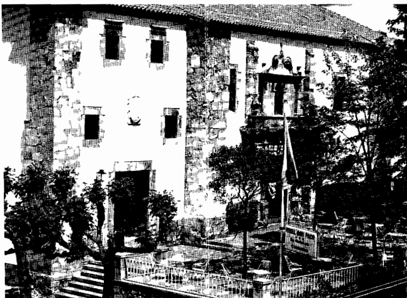
Fachada del convento e iglesia de agustinas. Llanes.
