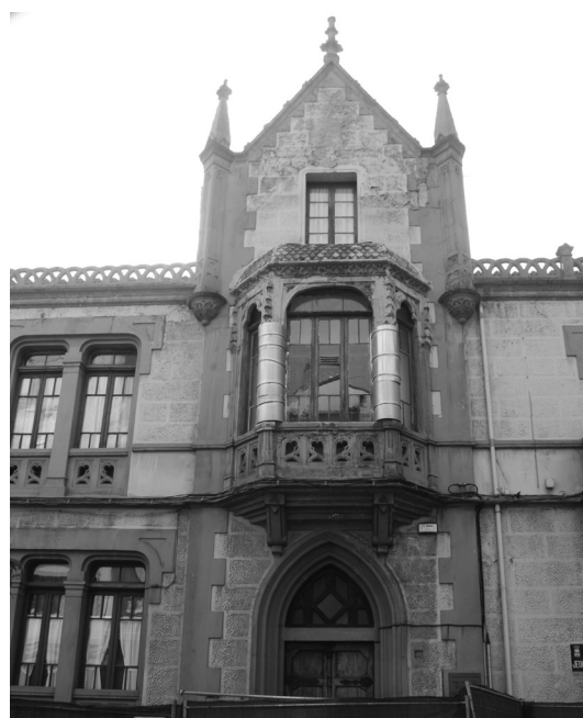
Fig. 2. Estado inicial, vallada y con bridas y puntales internos. (foto autores)
