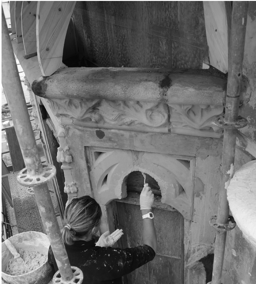
Fig. 2. Trabajos in situ. (foto autores)
