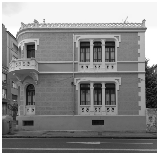
Fig. 4. Fachada Calle Carreño Miranda tras la restauración (© Marcos Morilla fotógrafo)
