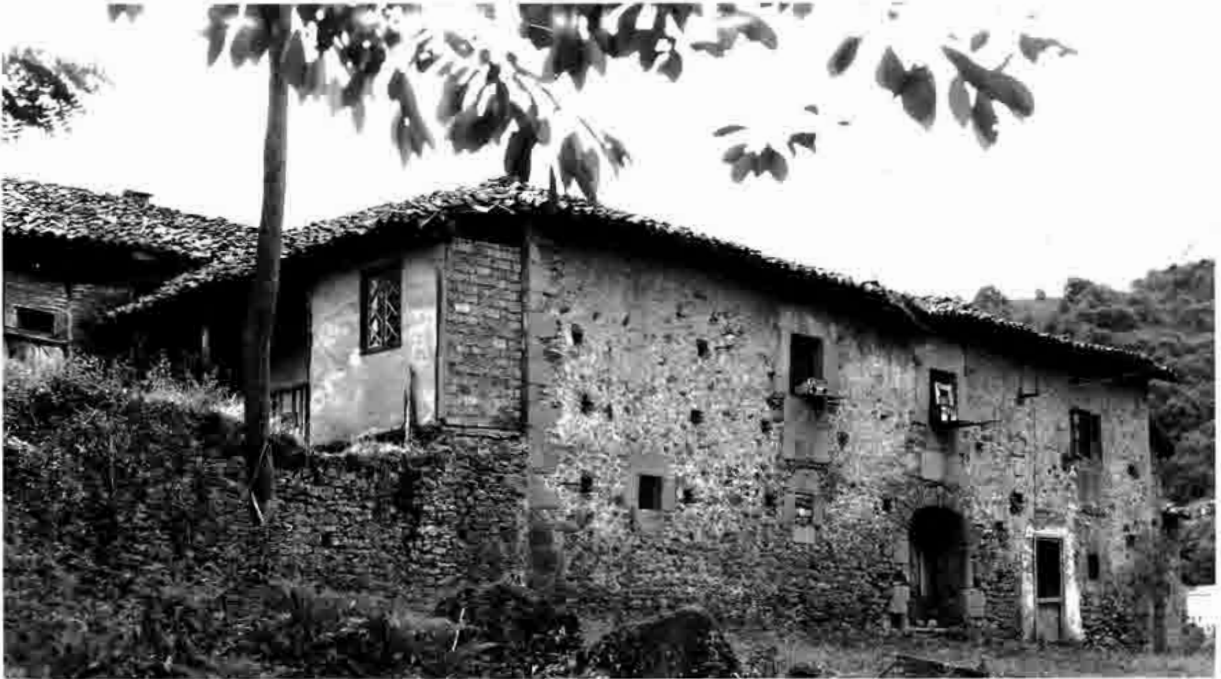
Lám. 10.—Fachada posterior del Castillo de La Cabezada.
