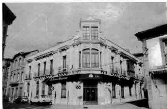
Lám. 41.-Edificio Banco Herrero Pola de Laviana
