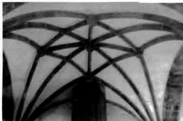
Lám. 13 bis.—Tanes. Bóveda.
