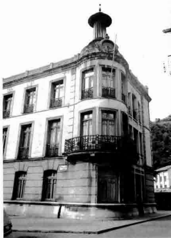
Lám. 47.-Sotroñdio. Antiguo Ayuntamiento
