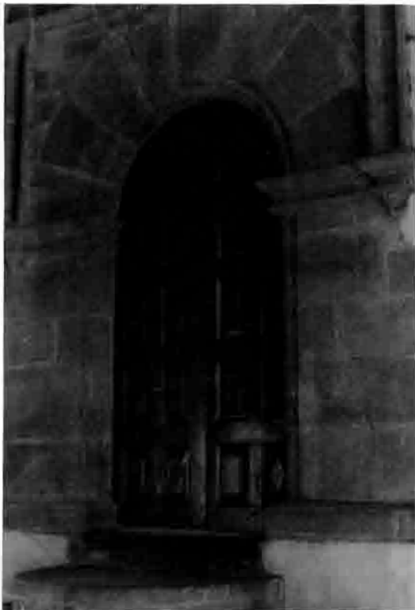
Lám. 16.—Tanes. Puerta occidental.
