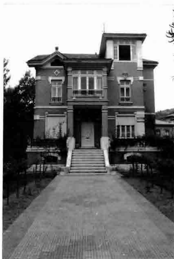
Lám. 115.—Villa en la calle José Antonio. Arriondas.
