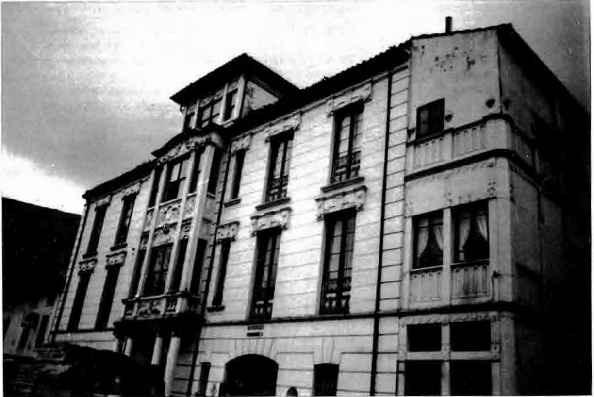
Lám. 70.—Edificio de estilo ecléctico-modernista, Buelles, Peñamellera Baja.
