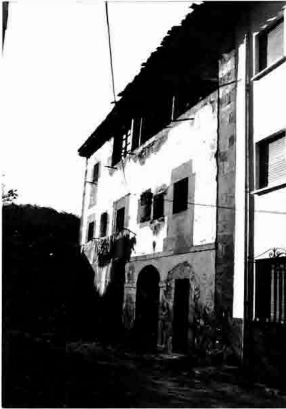
Lám. 77.—El Torreón de los Mestas-Cosío. B.º del Pindal o del Torreón. Arenas de Cabrales.
