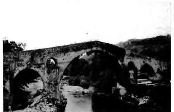
Lám. 60.—Puente romano. Cangas de Onís.
