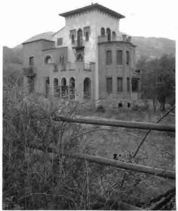
Lám. 120.-Medievalismo revivalista en la arquitectura contemporánea. El Puente. Parres.
