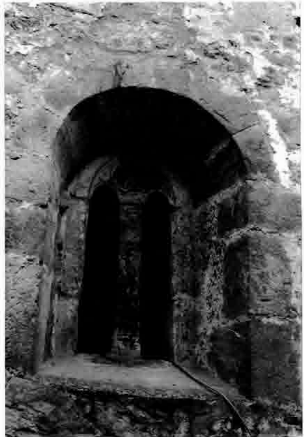
Lám. 5.—Ventana de la cabecera, Abamia, Cangas de Onís.
