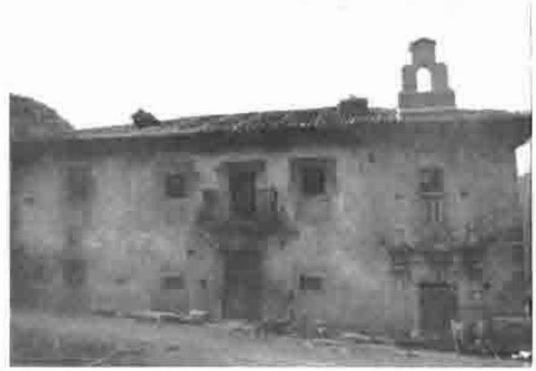
Lám. 40.—Palacio de Hoyos en Bores. Peñamellera Baja.
