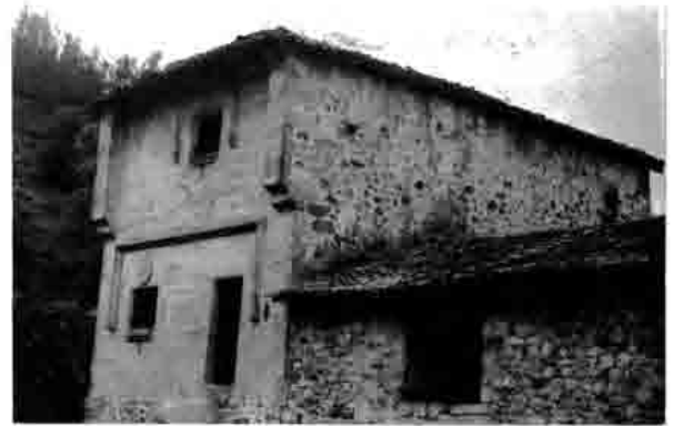
Lám. 8.—Torre siglo XVI. Intrialgo. Cangas de Onís.
