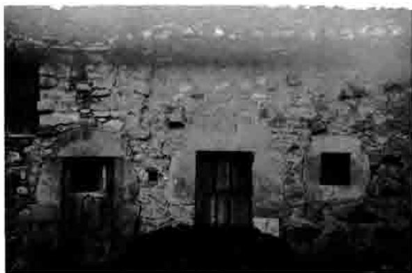
Lám. 76.—Casona del Barrio del Río, Arenas de Cabrales.
