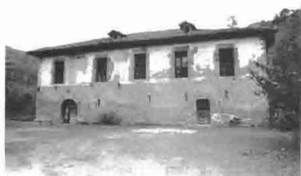
Lám. 24.—Palacio de Arriba. Cenera. Vista del conjunto.
