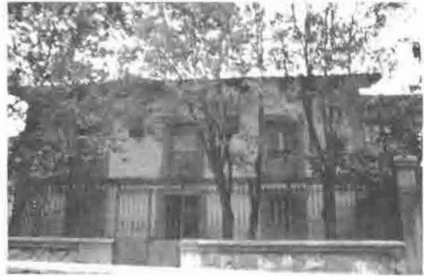
Lám. 92.-Ujo. Casa de los Huelga.
