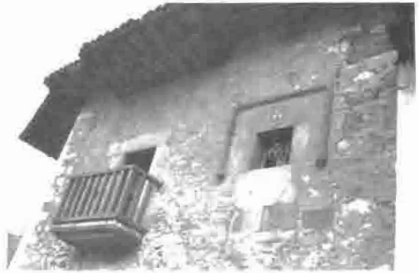
Lám. 15.—Agüera. Palacio de Quirós.
