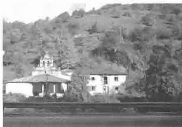
Lám. 112.—Las Puentes. Conjunto.
