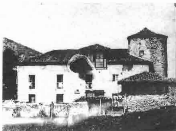
Lám. 55.—Casona palacio de la Torre o de los Hevia. El Pino. Documento fotográfico antiguo, aparece la torre medieval. Fachada principal.
