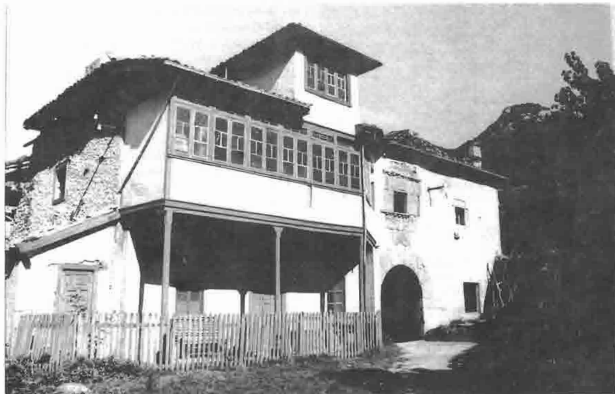
Lám. 60.—Casona de El Patio, El Pino. Vista de la fachada principal.
