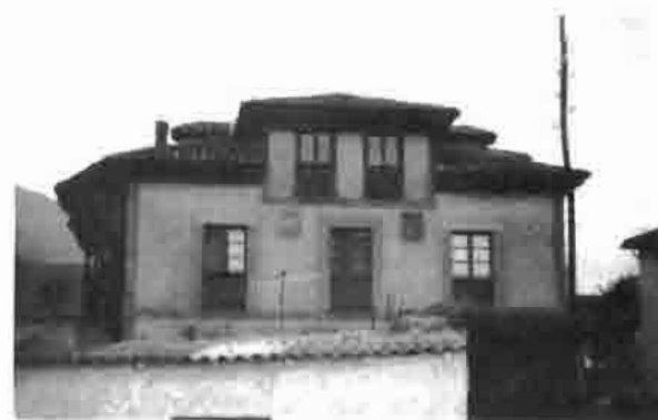
Lám. 6.—Caborana la Vieja. Casa de la Torre.
