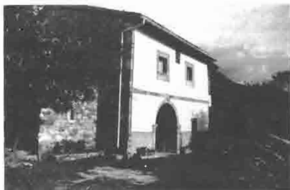
Lám. 130.—Peligano. Casona de los Posada Solís.
