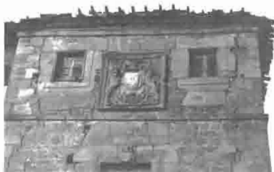
Lám. 45.—Edificio en su estado actual. Detalle.
