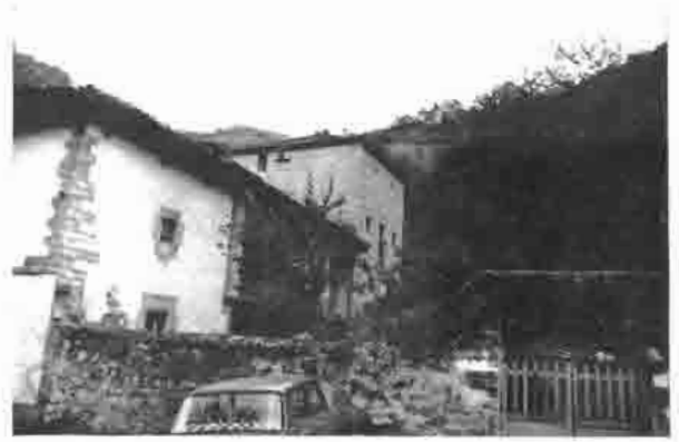
Lám. 64.-Vega. Palacio de los Vega Arias. Fachada de la torre.
