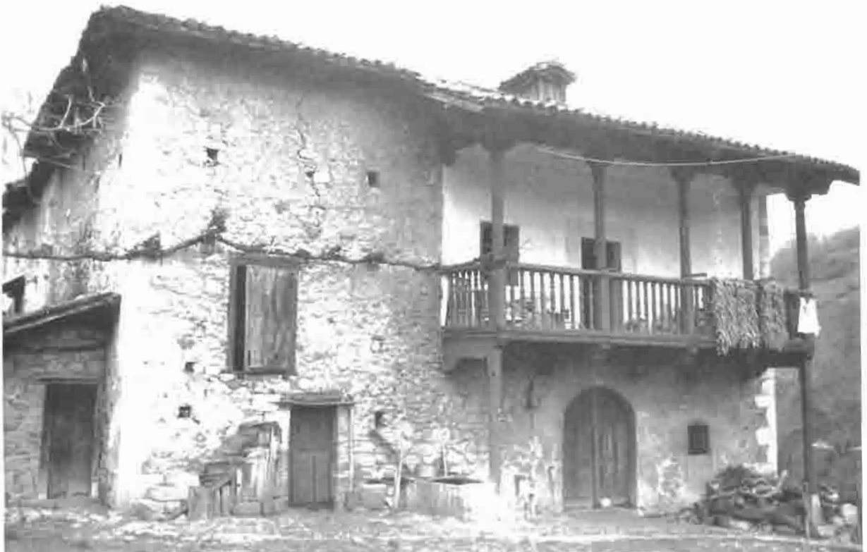
Lám. 14.—Agüera. Palacio de Quirós.
