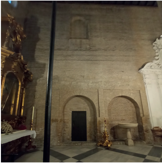
Fig. 5. Interior de la Iglesia de San Esteban, muro norte del templo, donde puede verse un arco cegado y bajo este, restos del material sobresaliente, Sevilla. (Fotografía: C. Vallecillo)
