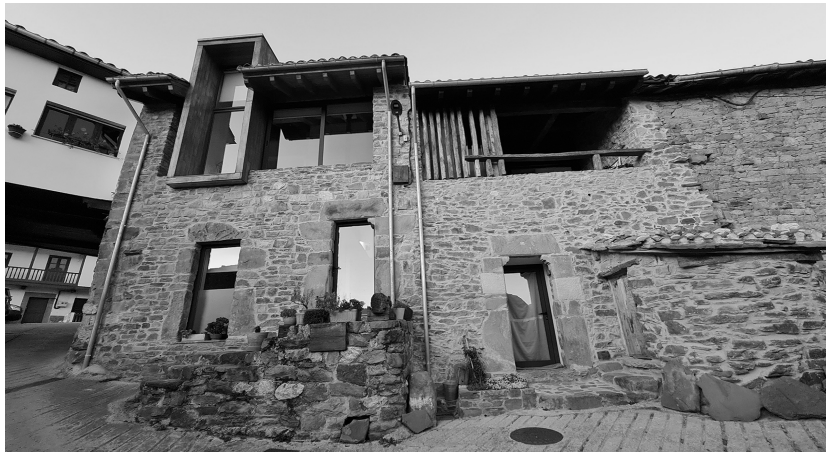
Fig. 4.- Adecuación de cuadras para vivienda en Prieres, Caso (María Valle González y Julio Valle Alonso)
