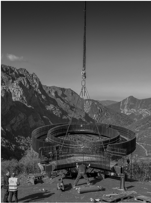
Fig. 4. Fotografía que recoge el momento en el que el tramo central del mirador es colocado sobre sus apoyos (octubre 2024). Foto: JRPA.
