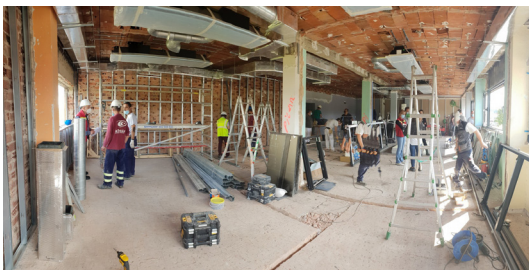
foto 3. ejecución obra en fases
