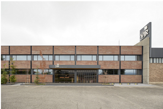
foto 6. fachada reformada @marcos morilla
