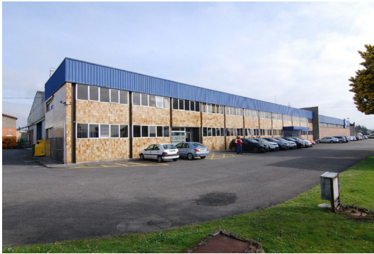
foto 1. estado inicial fachada
