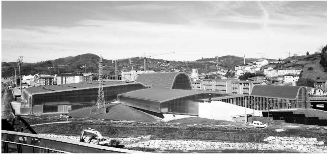
Fig. 4. El edificio desde La Felguera. © Carlos Casariego.
