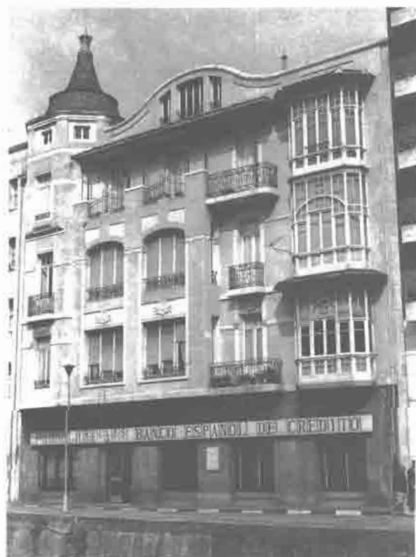
Fig. 17.—C/ Olavarrieta, 4-6, LUARCA
