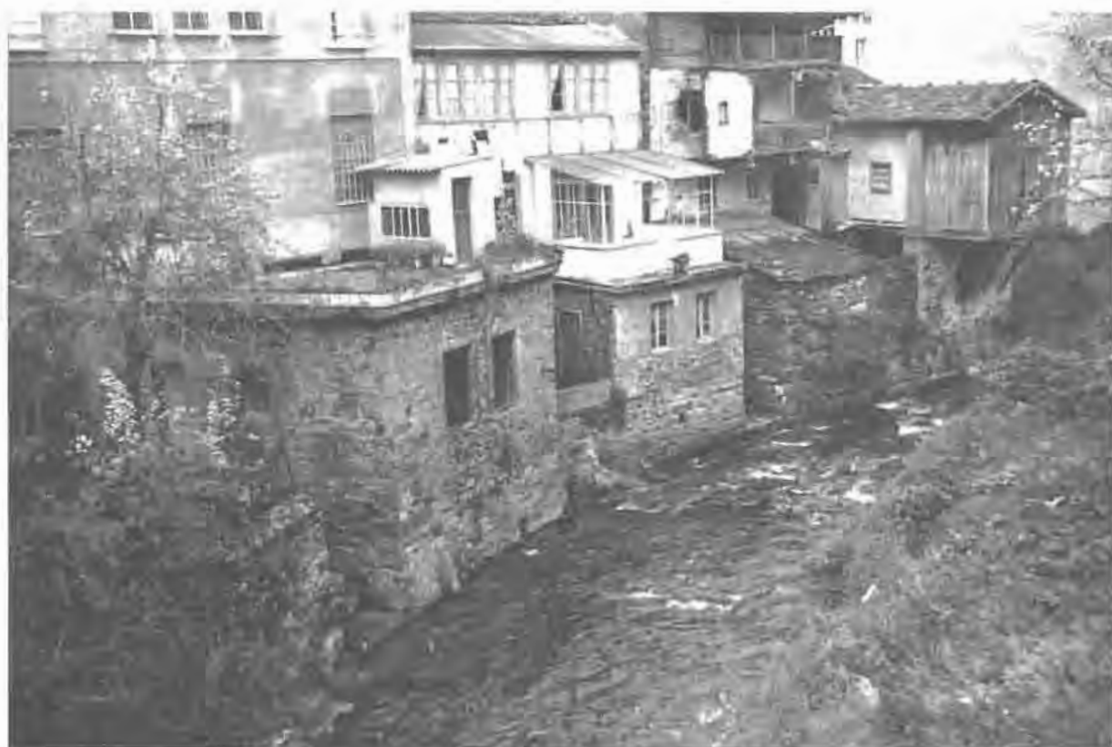
Lám. 33.—Pola de Allande. Casas cimentadas en el lecho del río.
