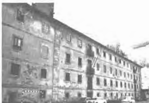
Lám. 66.—Monasterio de Corias. Fachada trasera.
