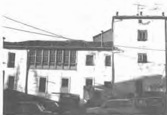
Lám. 97.—Palacio de Merás. Vista lateral. Tineo.
