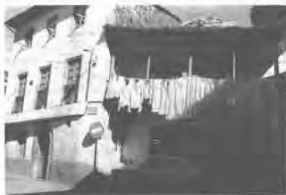
Lám. 28.—Casas de la calle Fuente, esquina a calle So el Mercado, Cangas del Narcea.
