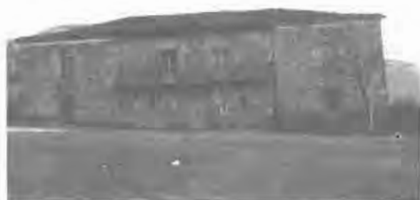
Lám. 80.—Fachada delantera del palacio de Jarceley, Cangas del Narcea.
