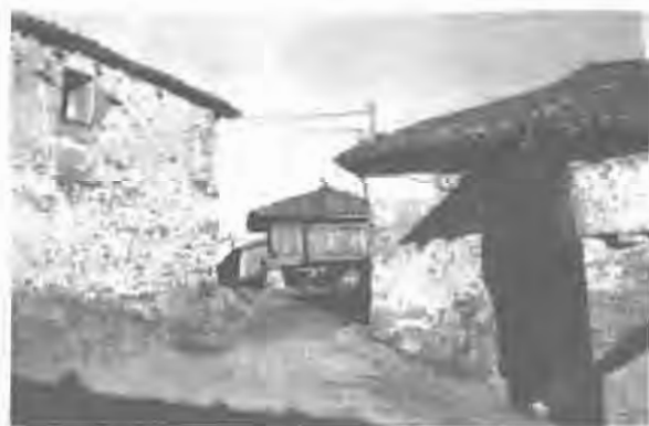
Lám. 25.—Un aspecto del barrio de Cimadevilla, Tineo.
