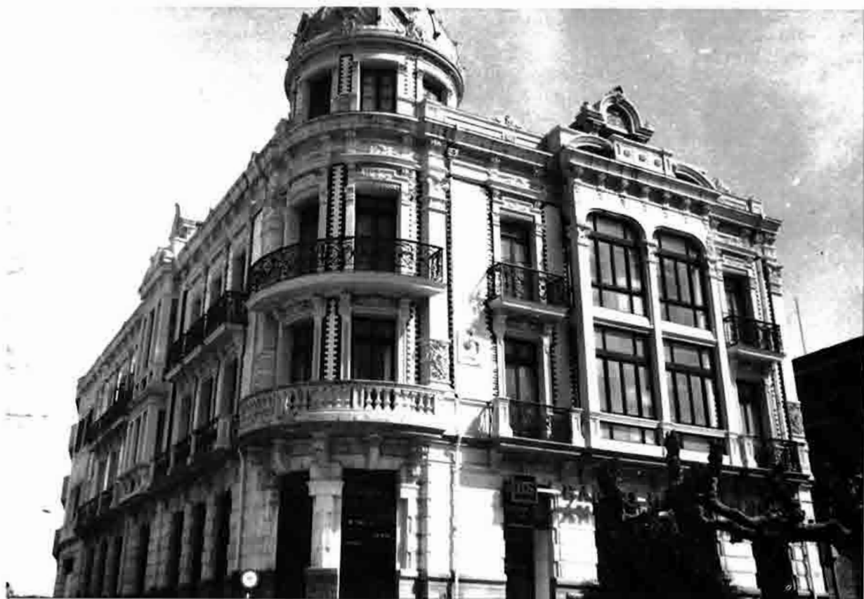
Lám. 73.—Banco de Santander. Calle Egidio Gavito.
