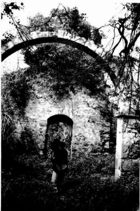
Lám. 50.—Monasterio de Santa María de Tina en Pimiango (Ribadedeva). Arco fajón de la nave central, vista desde la cabecera.
