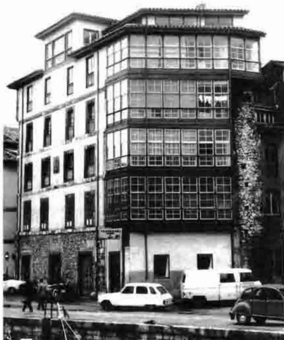
Lám. 93.—Casona en el puerto llanisco, incluida en la muralla medieval.
