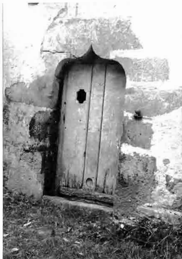
Lám. 22.—Portada del almacén del Palacio de los González Cutre, Prado.
