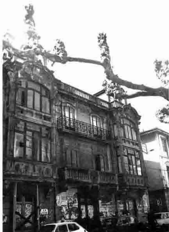
Lám. 72.—Casa de los Romano. Calle Egidio Gavito.
