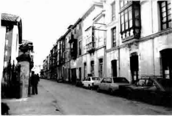
Lám. 103.—Conjunto de la calle Nueva.
