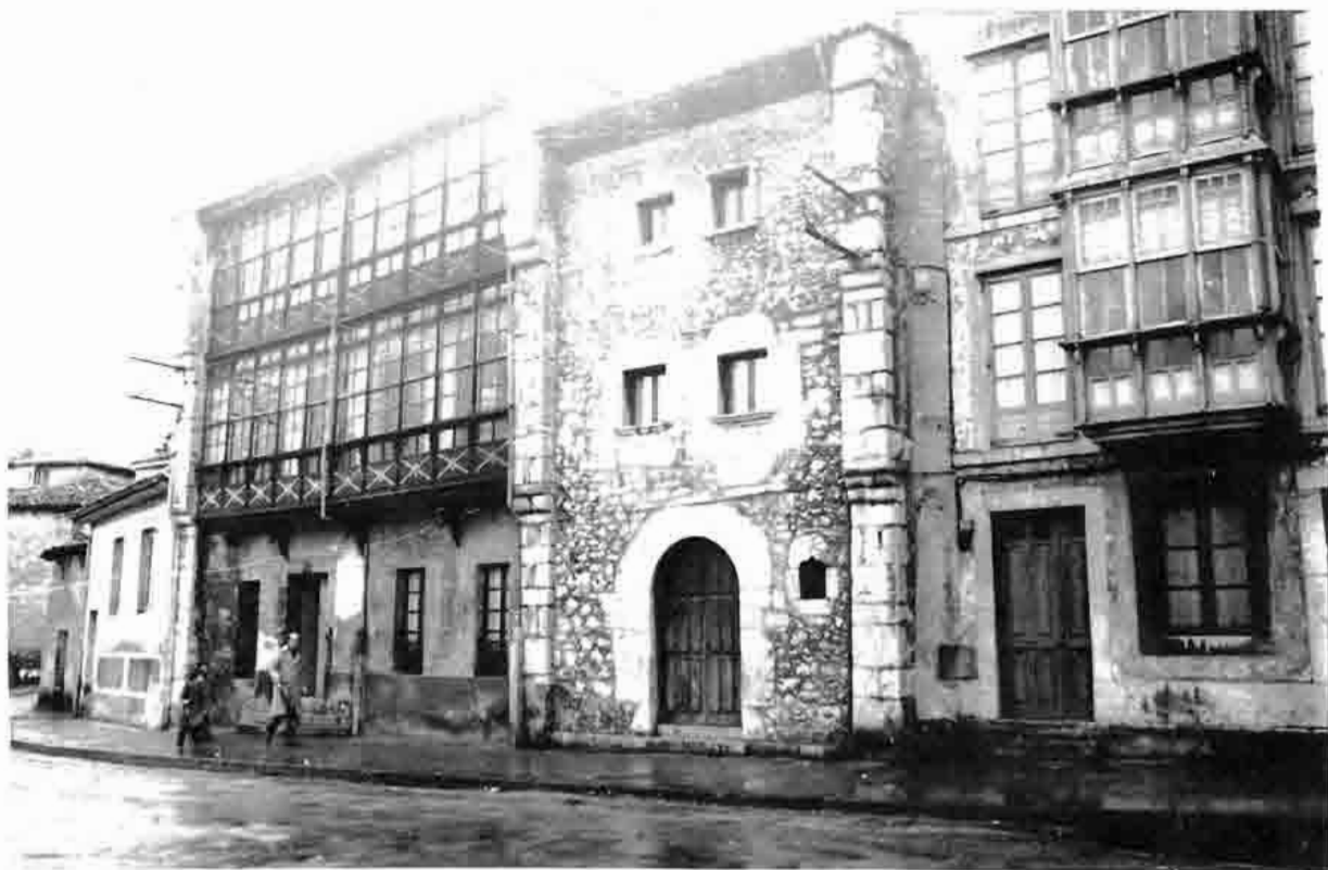
Lám. 96.—Casona del siglo XVI en el puerto de Llanes.
