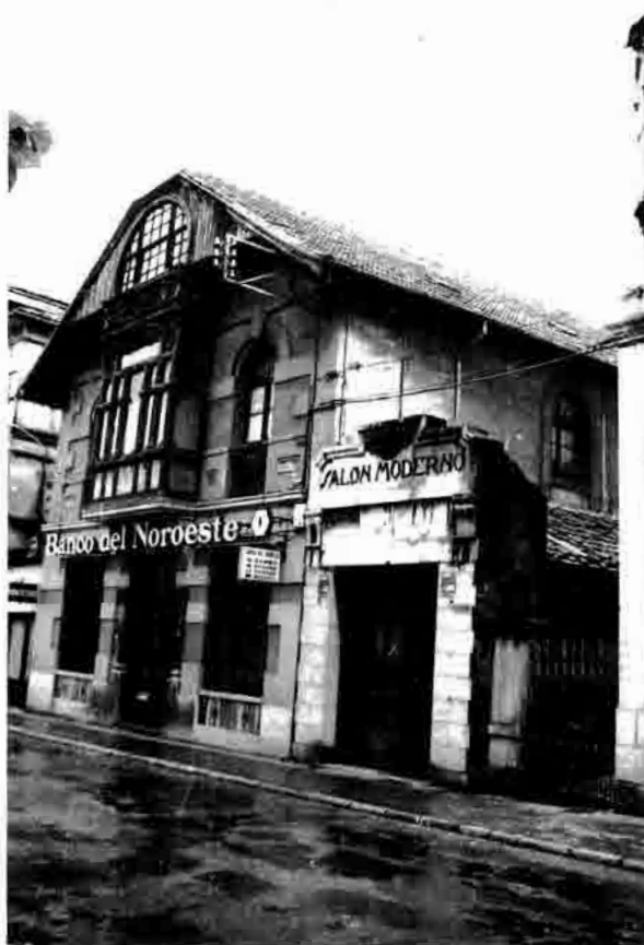
Lám. 102.—Edificio del Banco del Noroeste. Calle de las Barqueras, s/n. Llanes.
