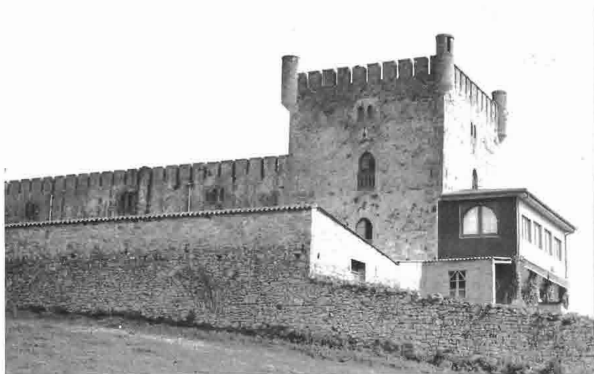
Fig. 81.—Antigua torre de los Valdés en San Cucao de Llanera.
