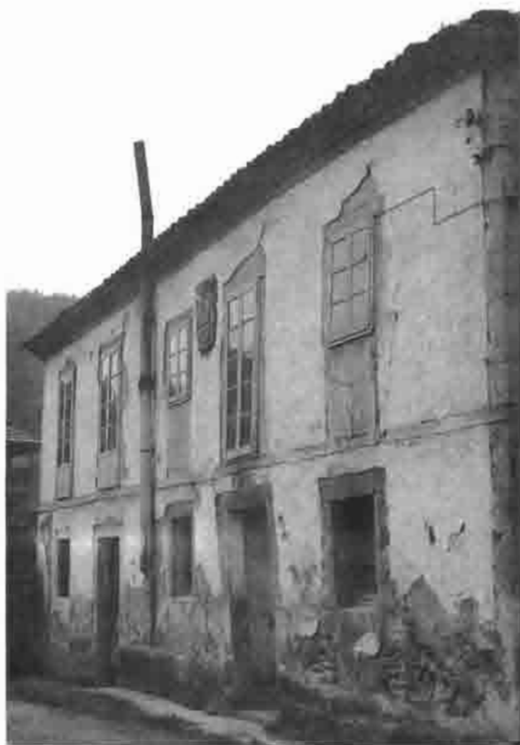
Fig. 71.—Casa de los González Llanos en Biforcós, Bañugues.
