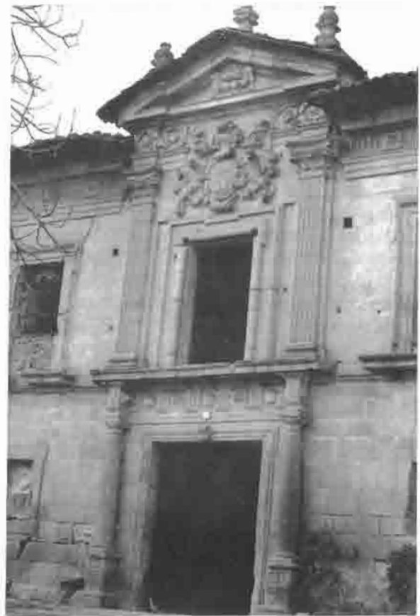
Fig. 30.—Fachada sur del Palacio de Celles, Siero.
