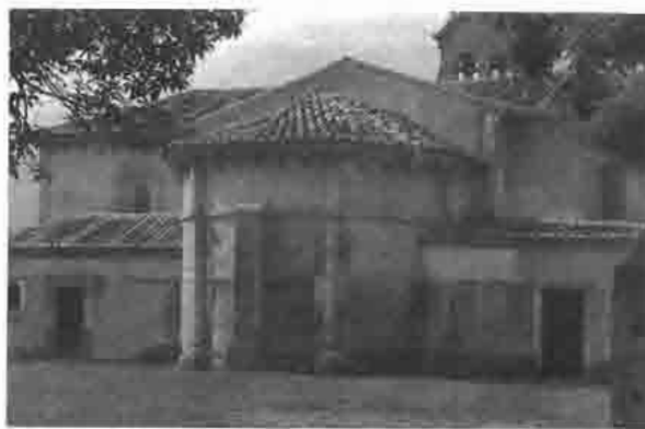
Fig. 90.—Ábside de la iglesia de San Juan de Priorio, Oviedo.
