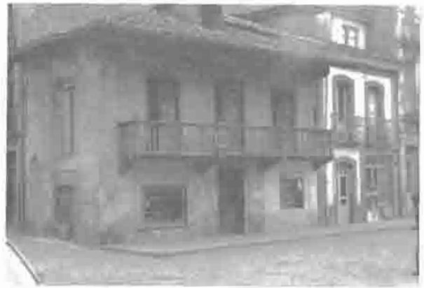
Fig. 9.—Casa en la calle San Antonio. Alero y balcón «barrocos» sobre estructura popular. Pola de Siero.
