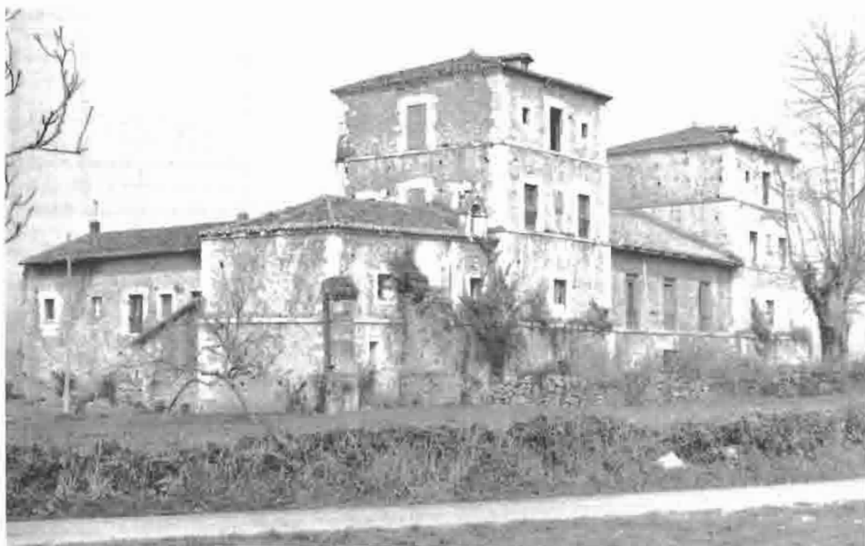
Fig. 82.—Palacio de Villanueva en San Cicero de Llanera.
