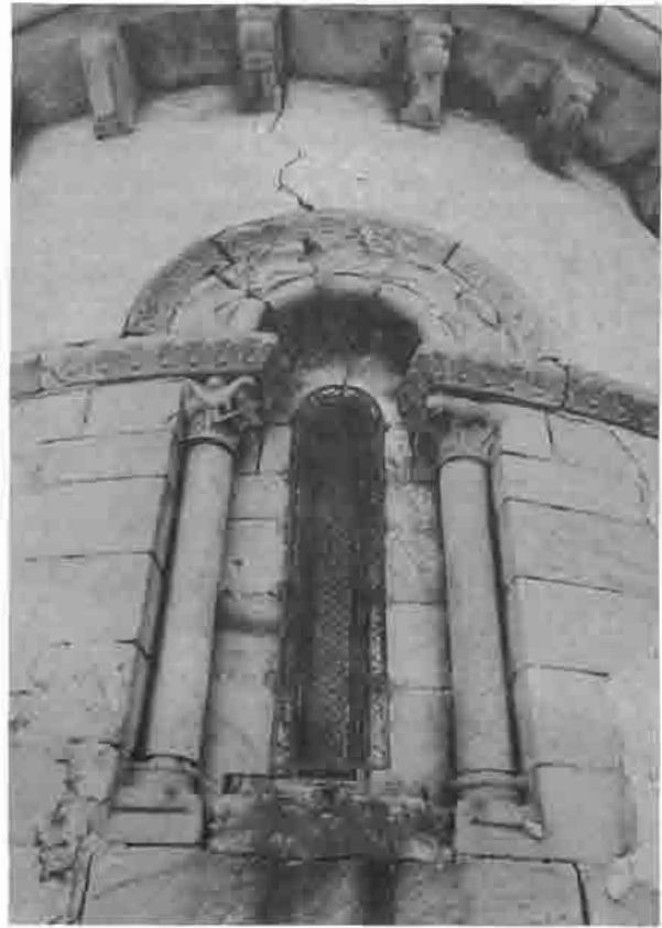
Fig. 53.—Ábside de la iglesia de San Andrés de Ceares. Gijón.
