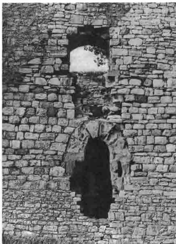
Fig. 17.—Torrexón de Prendes. Variedad de material y de etapas constructivas.
