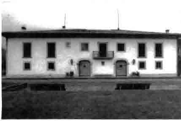
Lám. 25.—Casa de Argüelles y Las Huelgas, Villamayor. Piloña.
