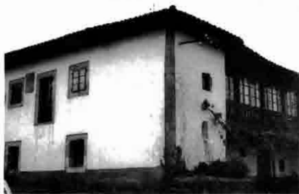
Lám. 47.—Casa de los Llano. San Román. Piloña.
