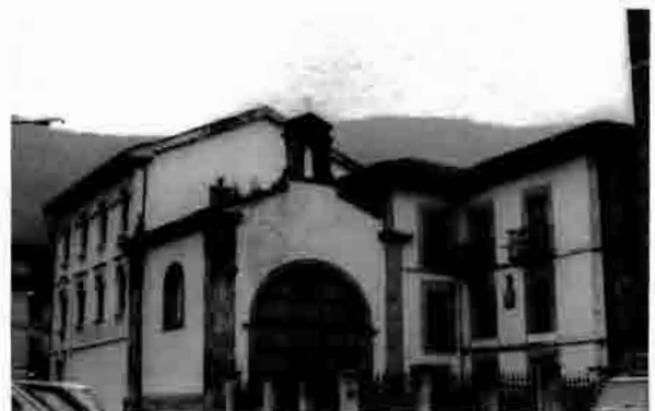
Lám. 13.—Casa de Cobián. Infiesto. Piloña.
