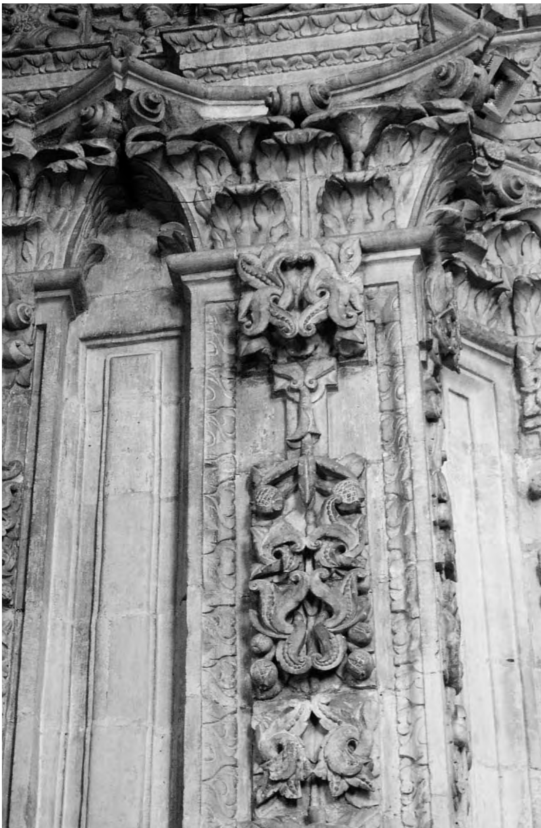
Capilla de Santa Eulalia (catedral de Oviedo). Detalle de una pilastra.
