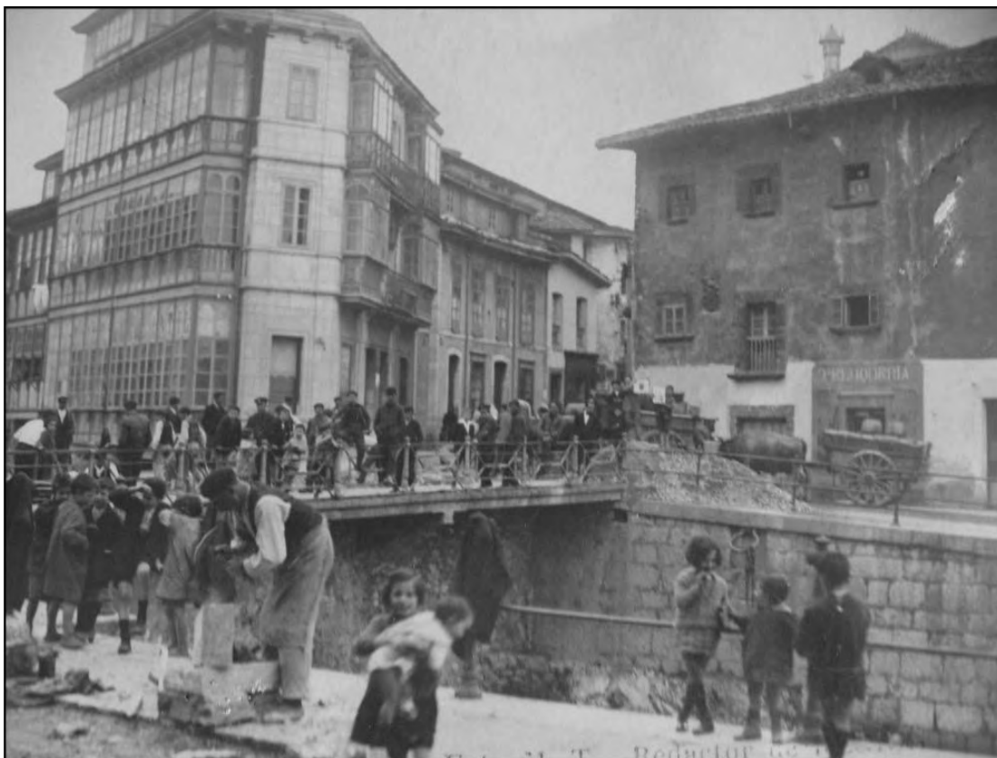
5. Fotografía de la época. Cuadrilla de trabajadores de Posada Noriega durante la construcción del puente de la Villa de Llanes.
