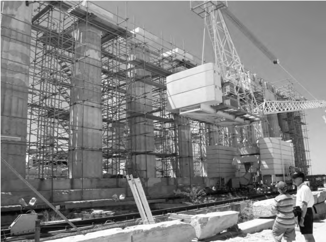
Figura 5. Columnata norte del Partenón en agosto de 2007. En el proceso de anastilosis en curso se reintegran piezas en mármol pentélico, cuya textura y color se diferencian radicalmente de los elementos originales. Los tambores incompletos se reponen añadiéndoles el material faltante. El "efecto collage" será corregido mediante el patinamiento de los elementos repuestos. Foto Pablo Herrero.
