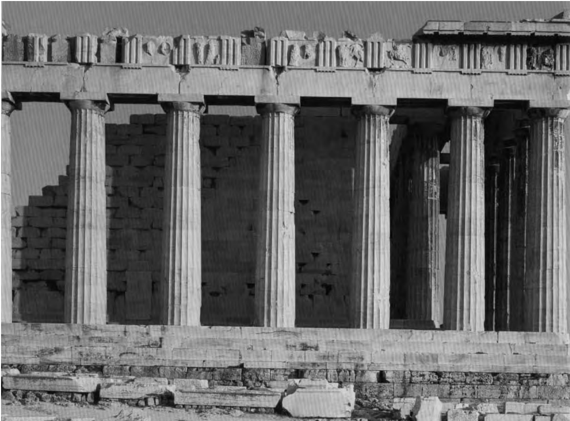
Figura 4. Columnata norte del Partenón, rehecha según los criterios de Nikolaos Balanos, con sus tambores de cemento y su textura "patinada" para integrarse con las piezas originales. Fuente: HADZIASLANI, Cornelia. Parthenon Promenades , Fundación Melina Mercouri, Atenas, 2001.
