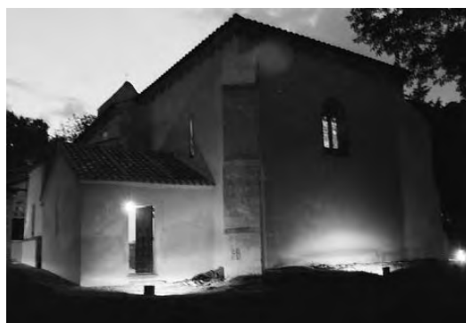
R.- Estado actual; Vista nocturna. Foto: Jesús Puras Higuera
