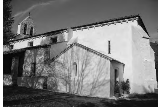
R.- Estado actual; Vista Sureste. Foto: Javier Arbesú Fanjul
