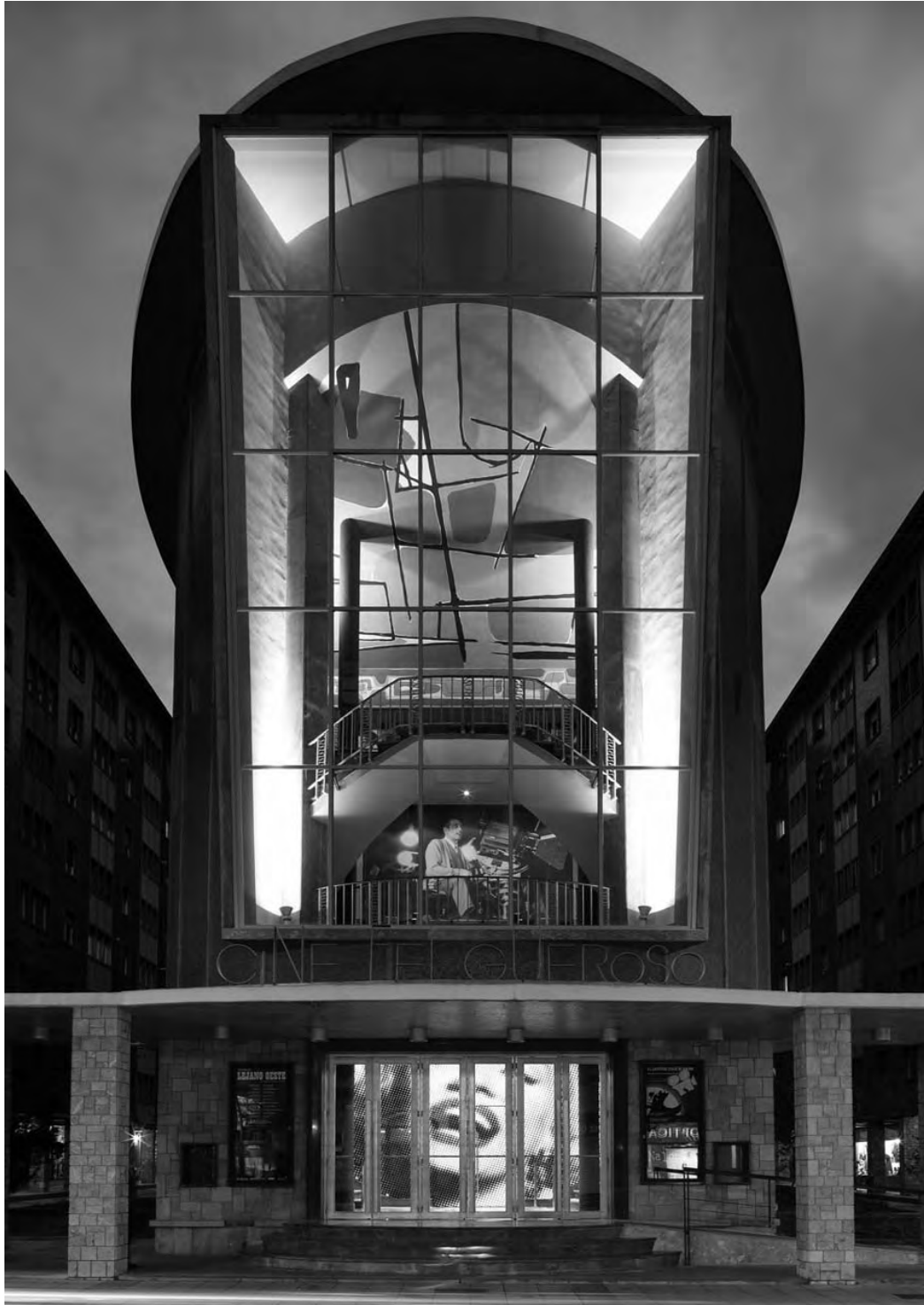
Figura 2. Fachada principal. Fotografía: Marcos Morilla
