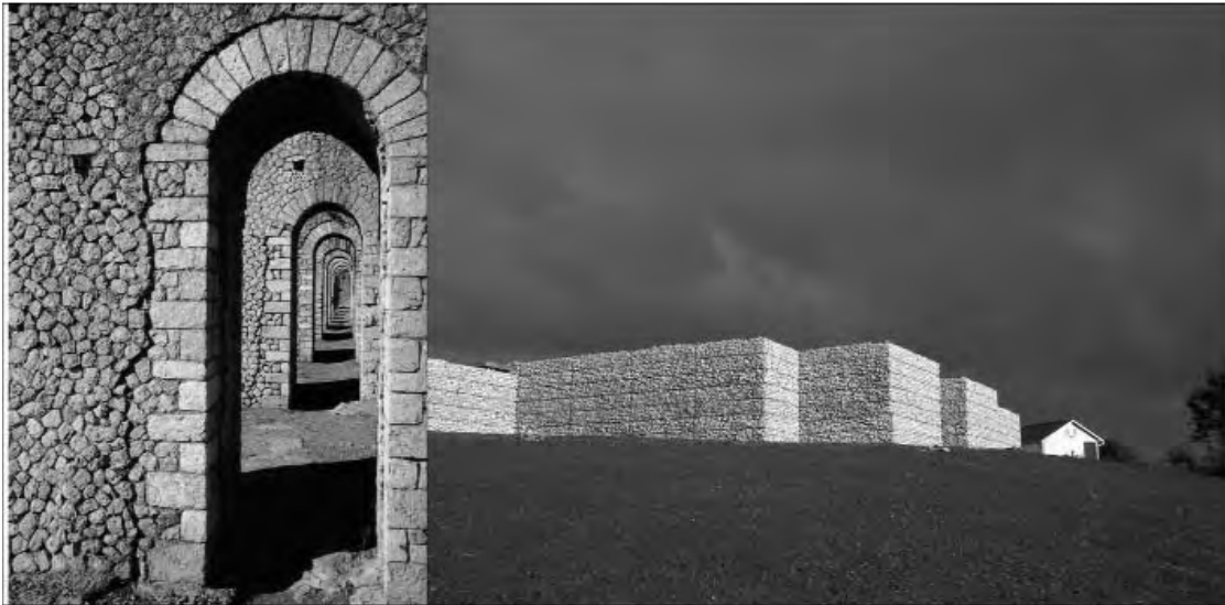
Figura 2. Fotografía de los muros de referencia y gaviones.
