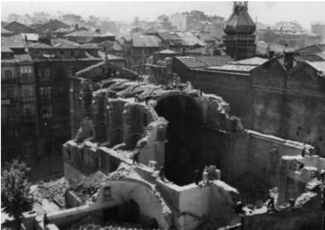
9. Capilla de los Puebla en la iglesia del convento de San Francisco. Inicio del derribo. Samot, 1936. Colección Víctor del Campo. Centro de Documentación de la Imagen de Santander (CDIS). Ayuntamiento de Santander.
