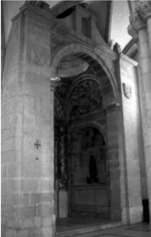
14. Capilla de San Antonio en el interior de la Catedral.
