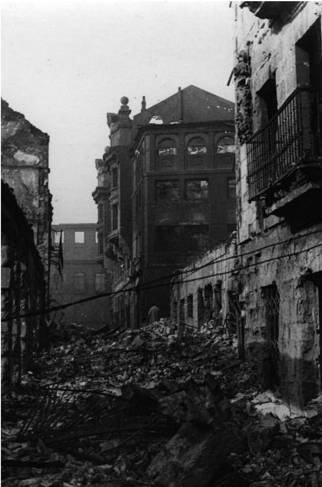
3. Palacio del Conde de Isla en la Calle de la Compañía tras el incendio. Autor desconocido. 1941. Colección Víctor del Campo. Centro de Documentación de la Imagen de Santander (CDIS). Ayuntamiento de Santander.
