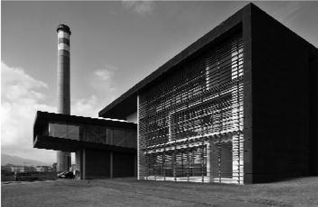
Fig. 4. Centro Tecnológico del Acero y Materiales Metálicos de Asturias, pieza del auditorio volada sobre el acceso. Fotografía: Marcos Morilla.
