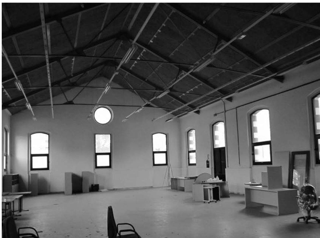
Fig. 1. Estado previo a la reforma de la nave-taller 115. Arriba, fachada y abajo, espacio interior objeto de la reforma.
