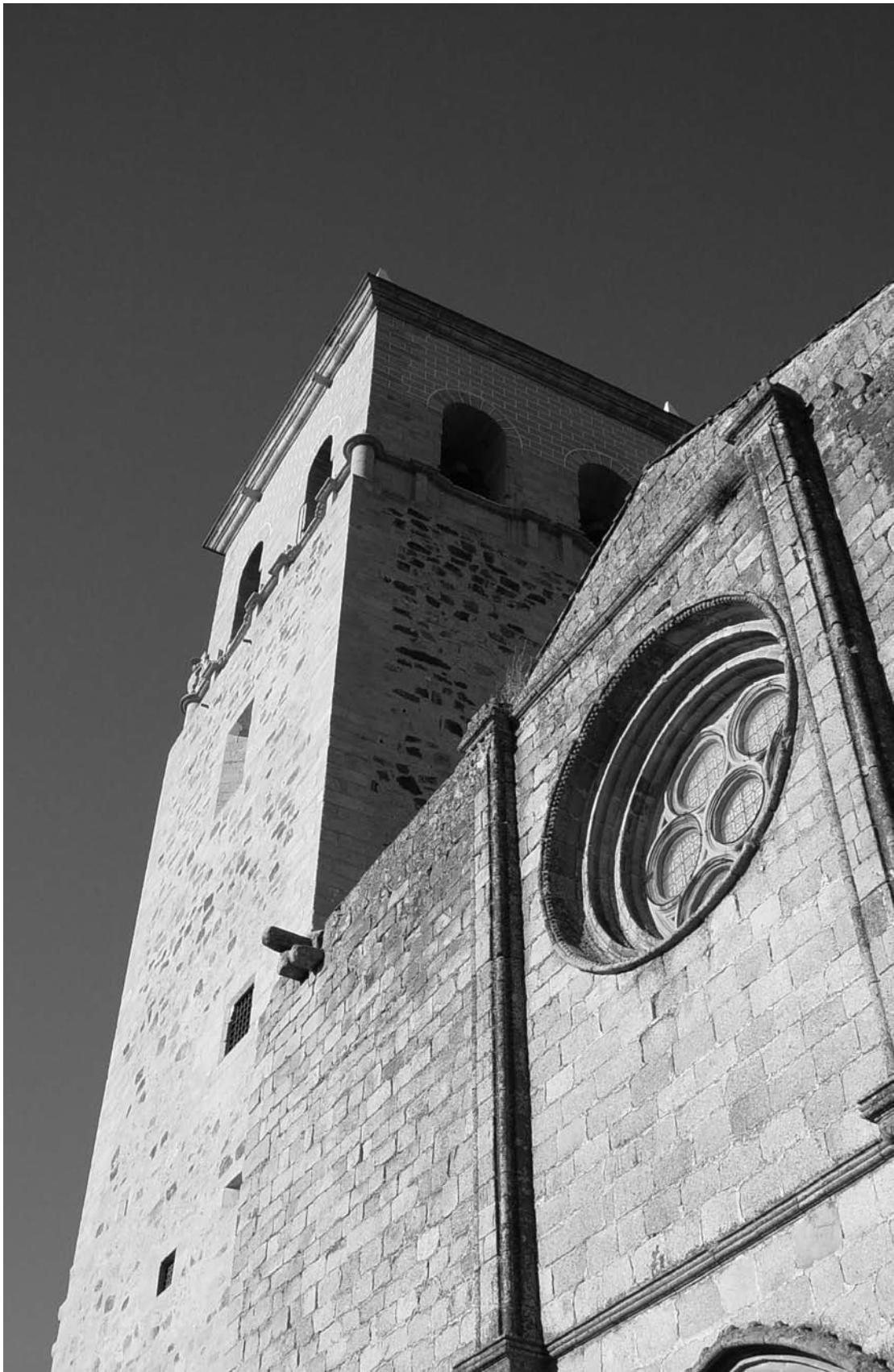
Santa María La Mayor. Torre Nueva (detalle).
