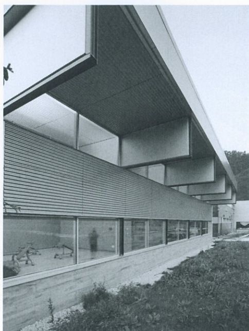
Exterior a Sur. (foto Marcos Morilla).
