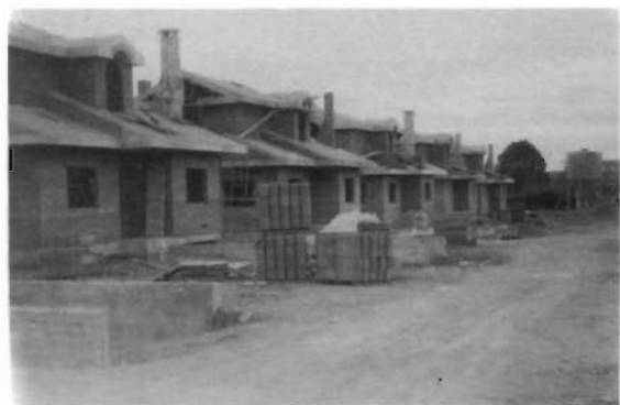
Fig. 12. Hilera de cuasiadosados de "La Pomarada", en construcción.
