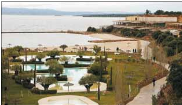
FIG. 18. Piscinas, playa fluvial represada y Hotel Medical-Spa en construcción. Fuente: Empresa MIV.
