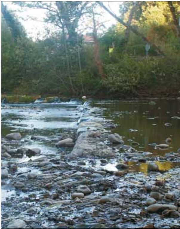
FIG. 8. El azud de la calcera unificada desde la ribera derecha del Saja, 2002; al fondo, a la izquierda, el inicio del canal de derivación. Fotografía de F. González Rebanal.
